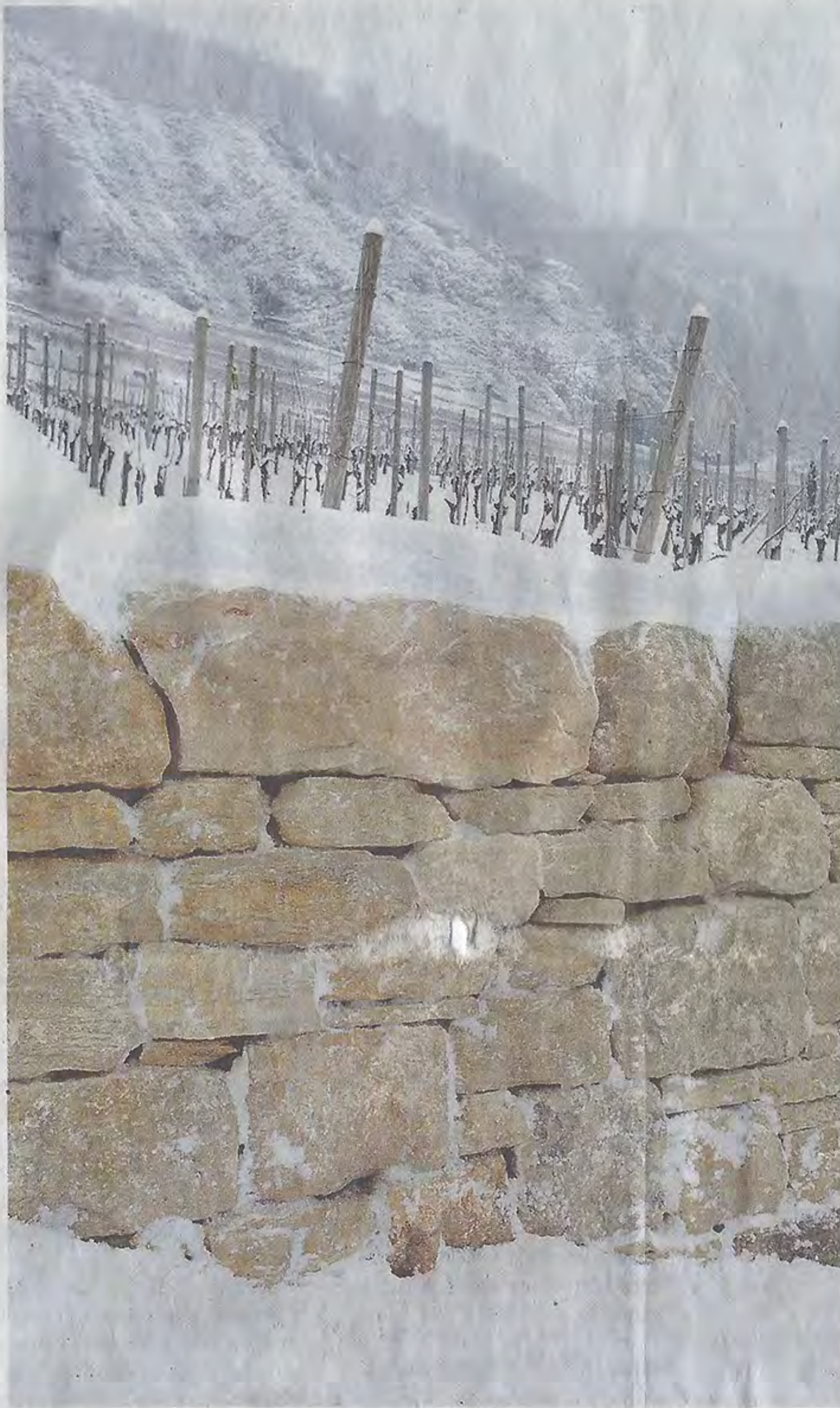
An dieser Trockenmauer arbeiteten zwei Männer fast zwei Wochen lang. Dafür ist sie äusserst stabil und bietet Lebensraum für Pflanzen und seltene Tiere. Adrian Streun
