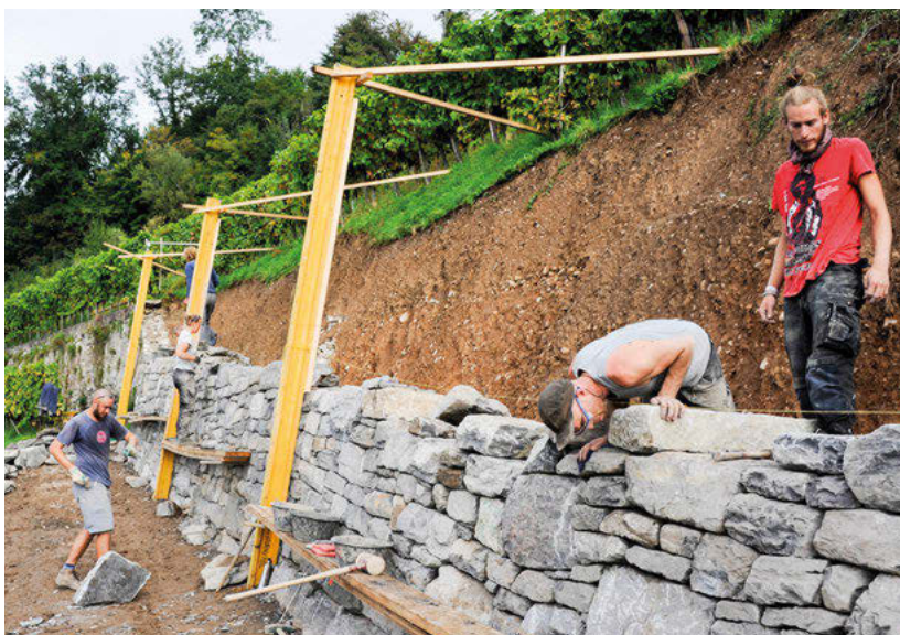
Trotz schmalem Arbeitsstreifen und viel Material bauten die Trockenmauerspezialisten die neue Trockenmauer mit hohem Fachwissen wieder auf.
